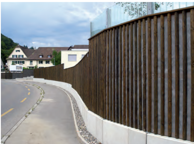
Paroi antibruit avec composants en bois imprégné
